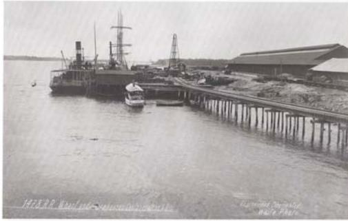
**L**os muelles, al igual que las vías del ferrocarril, estaban sobre pilotes de acero que les daba la solidez que no ofrecía el terreno pantanoso de la ribera del Coatzacoalcos. Las bodegas estaban sobre tierra más elevada.
